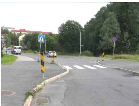
Bilde 15 (Venstre): Innsnevring av veibanen i Rødbergveien.
